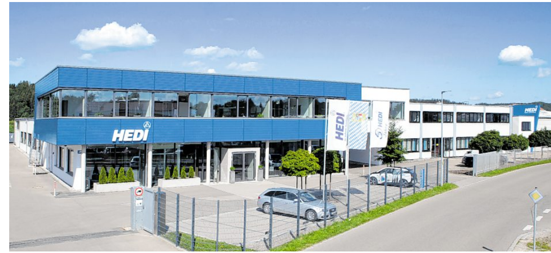
Heute vereint die HEDI GmbH im Verwaltungsgebäude und modernen Hallen die hauseigene Produktion und die Abteilung für Kabelkonfektion und Schaltschrankbau unter einem Dach.
